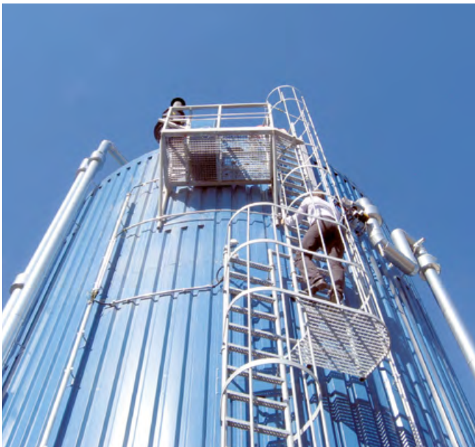
Der Klärschlamm wird in einem Faulturm von Bakterien zu Biogas umgewandelt, mit dem sich Strom und Wärme erzeugen lassen.
